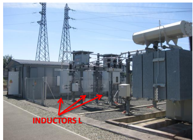
Fig. 20 - Evron Substation - STATCOM exterior photos.
