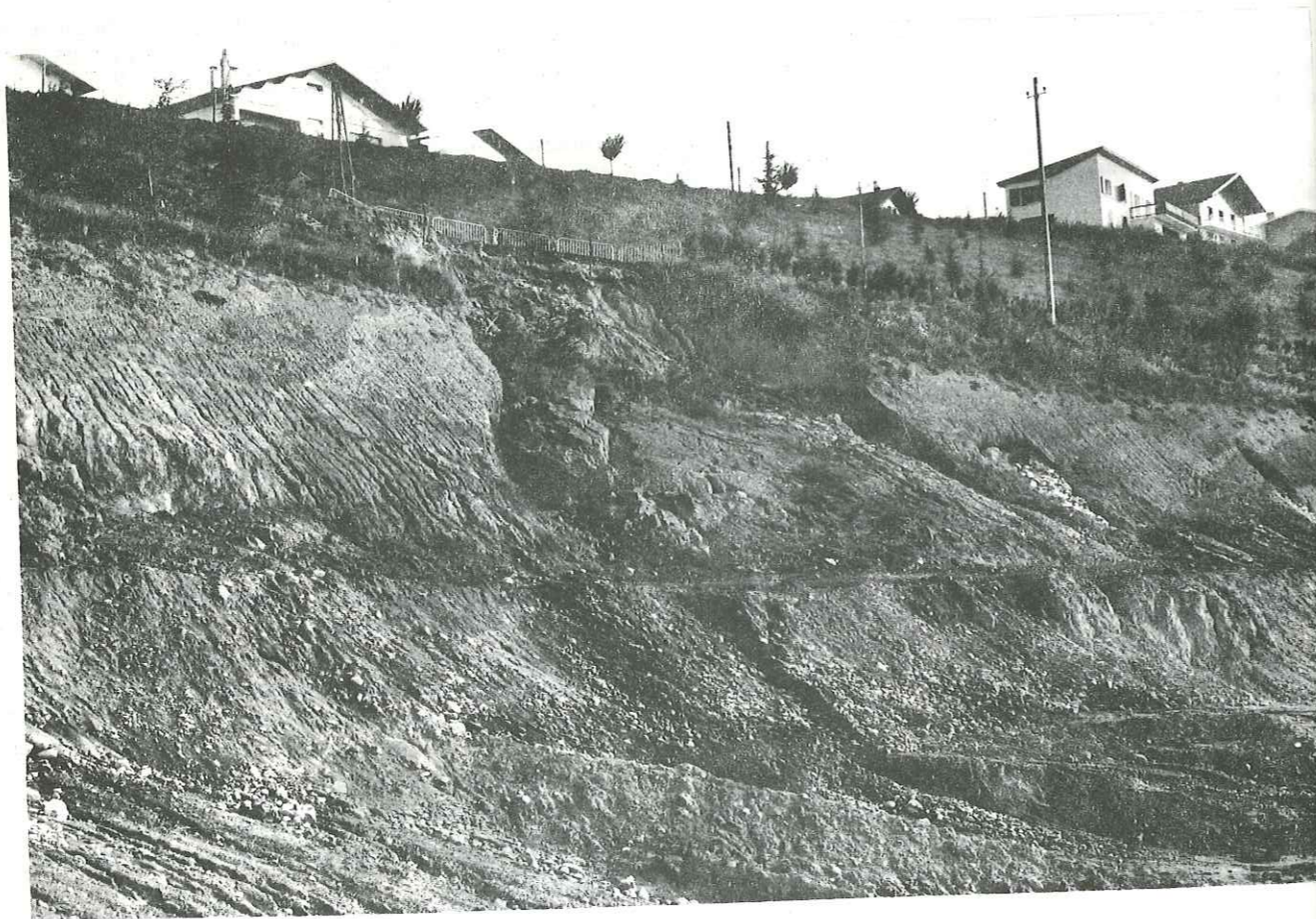
Photo n° 1 - Glissement de Montmélián (type landslide par rotation)
