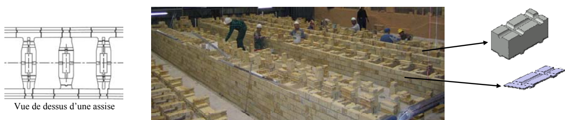
Figure 25 : piédroits en cours de réalisation et géométrie des briques et joints.
