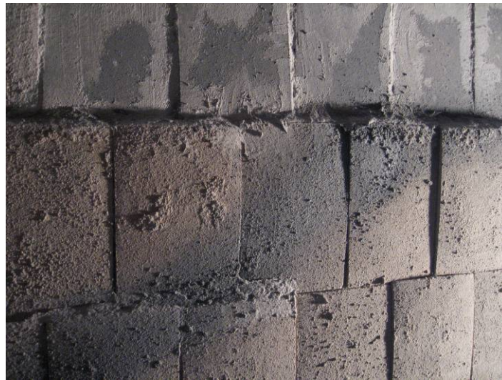
Figure 80 : Paroi d'UVEOM après réparation (tuiles SiC liaison oxyde)
