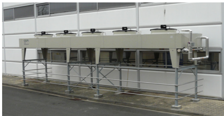
Figure 22. Photo du condenseur à air situé sur le site des Renardières d'EDF
