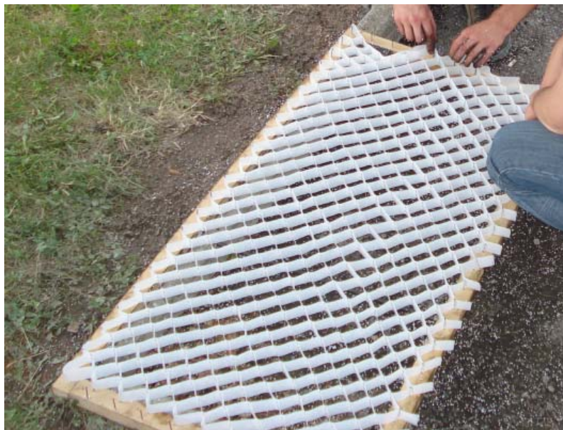
Figure 87. Mise en place d'une nappe sur le cadre.
