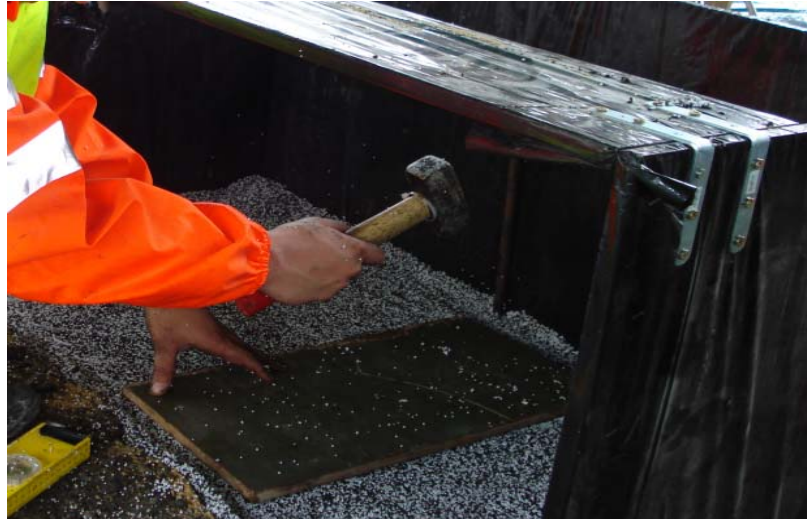
Figure 94. Deuxième étape de compactage du matériau
