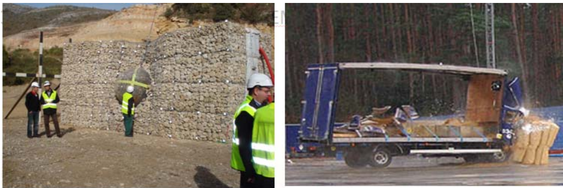
Figure 40. (gauche) merlon de protection contre les chutes de blocs à double parements (Visite du site d'essai REMPARE) – (droite) merlon de protection Defencell© sans parement contre les chocs de véhicules.
