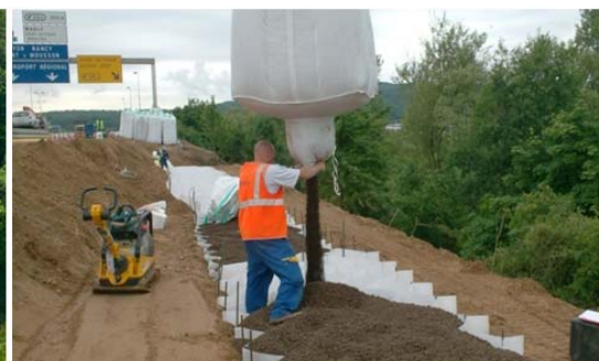
Utilisation de matériaux allégés Élargissement de l'A31, Jouy-aux-arches (57)
