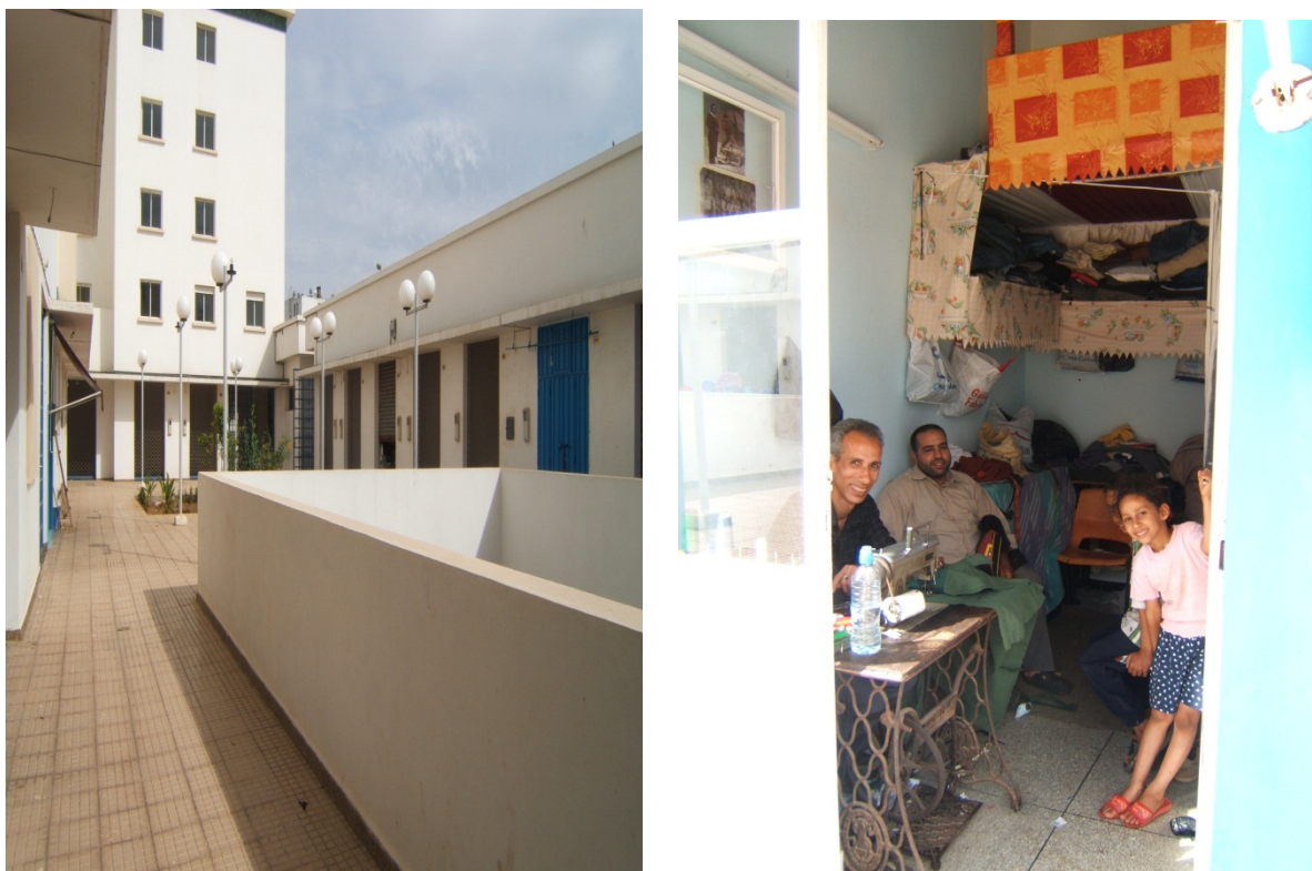
Les locaux commerciaux de la halle. A droite, la boutique d'un couturier. Clichés : H. Essahel, 2007
