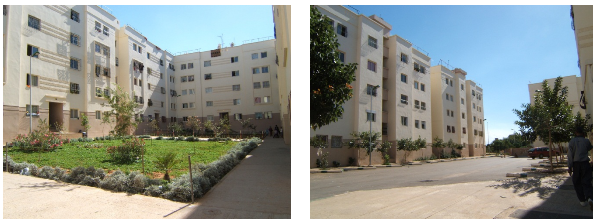
Figure n° 42 : La Cité de relogement de Mers El Kheir et ses espaces extérieurs
