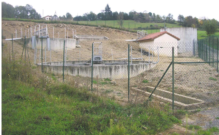
Photo 24 : Station d'épuration à Grazac (Y. BENMALEK)
