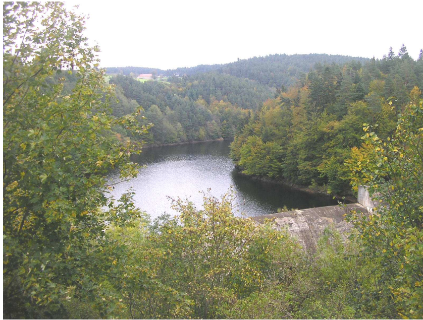
Photo 17 : Le Barrage de la Chapelette (Y. BENMALEK)
