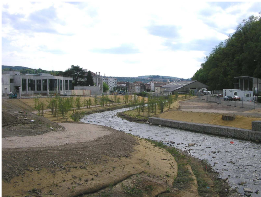
Photo 26 : L'Ondaine au Chambon-Feugerolles : gabions et revégétalisation des berges (Y. BENMALEK, 09.05.2009)
