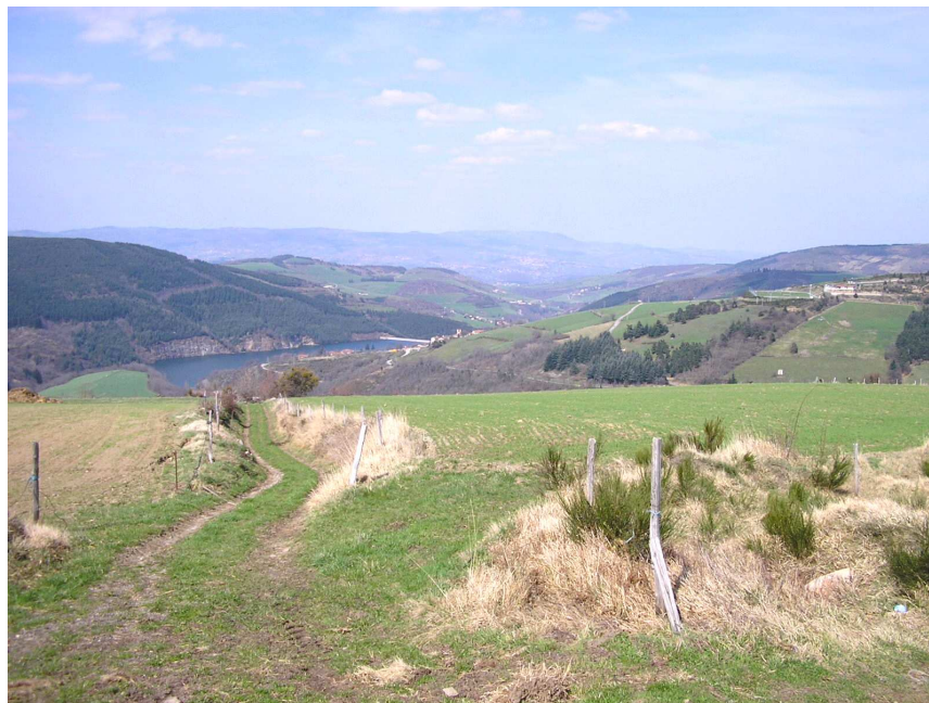
Photo 21 : Le Barrage du Dorlay (Y. BENMALEK)
