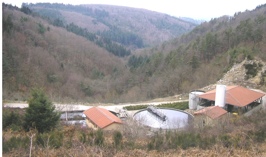
Photo 23 : La station d'épuration de Roche Moulin à Saint-Just-Malmont et la Vallée de la Gampille (Y. BENMALEK)
