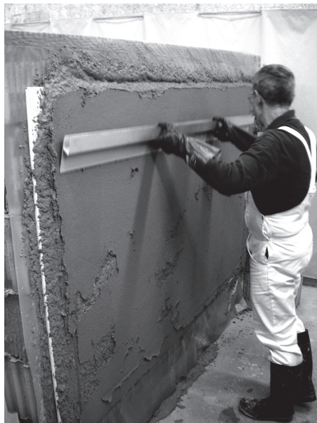
Figure 1.5. Lissage d'un mortier monocouche.
