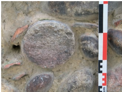
Tronçon de colonne employé dans le mur occidental de la sacristie de l'église Saint Michel
