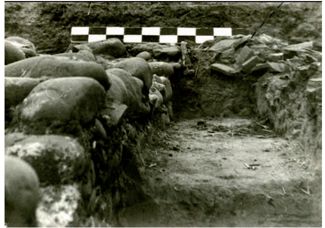
b : détail de la fondation et du dépôt de tegulae situé au sud (aire A), vue de l'ouest (d'après Vidon 1973)
