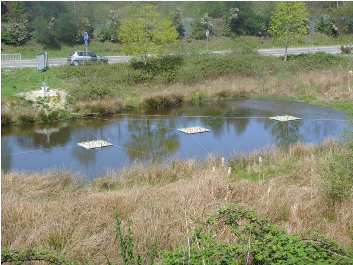
Figure 4-2 Vue d'ensemble des trois marais flottants implantés sur le bassin de rétention autoroutier
