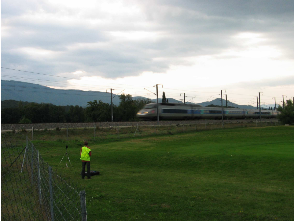
FIG. 3.23 – Vue du site de Montvendre pendant la campagne d'essais V360.
