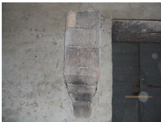
Fig. n° 126. A. Console et départ de l'arc doubleau. B. Inscription en remploi dans l'ébrasement de la fenêtre de la troisième travée (cl. M. Varano).
