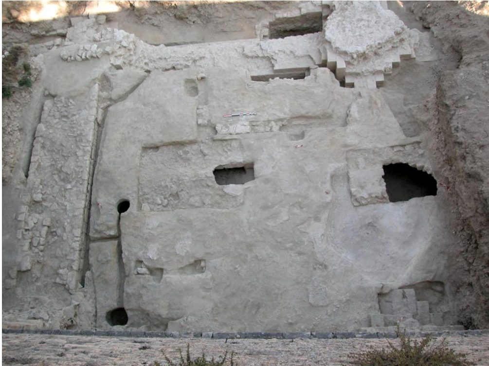
Fig. n° 31. La deuxième travée, vue du sommet du mur gouttereau ouest (cl. M. Varano).
