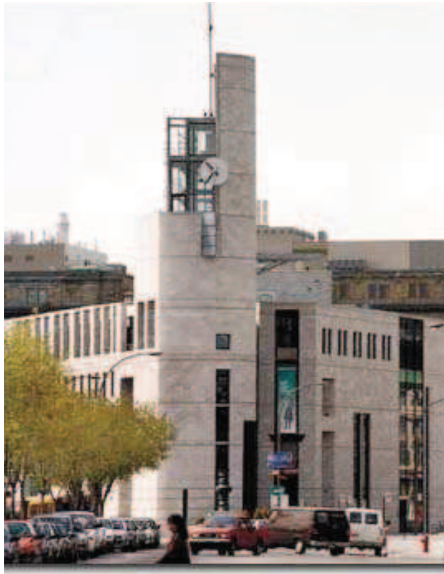
Le bâtiment de l'Éperon (source : www.vieux.montreal.qc.ca )
