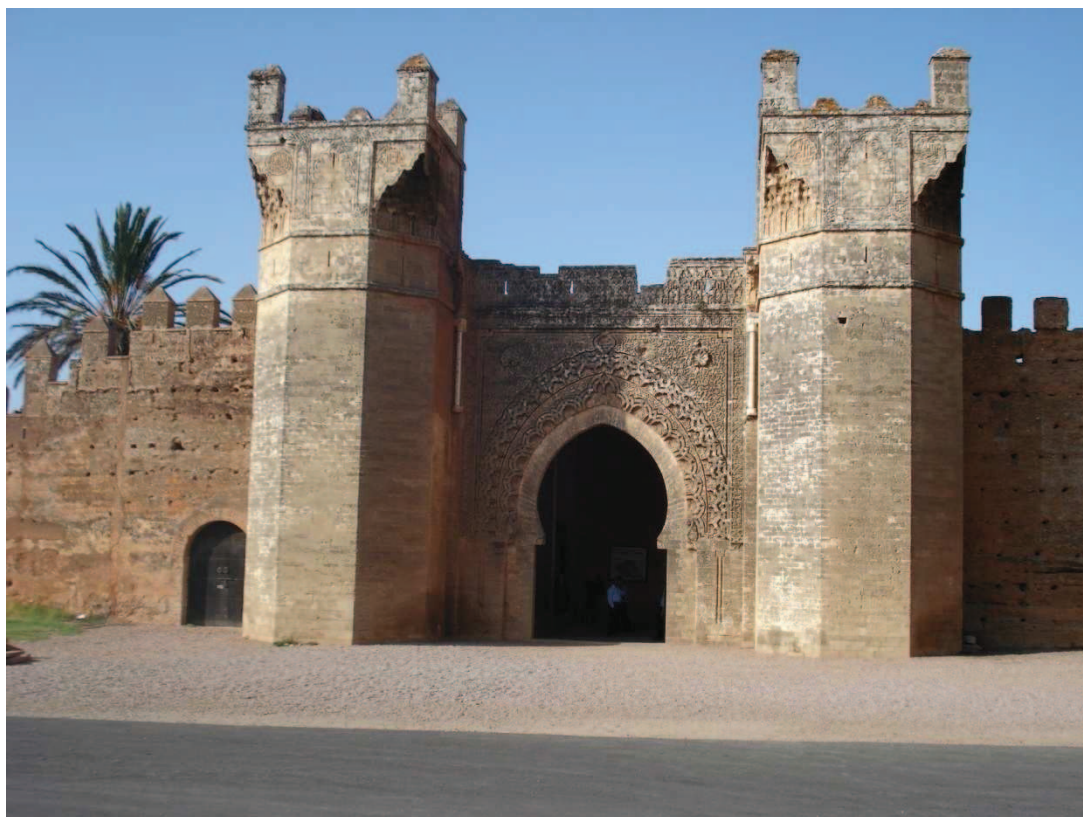
La Grande Porte de l'enceinte de Chellah
