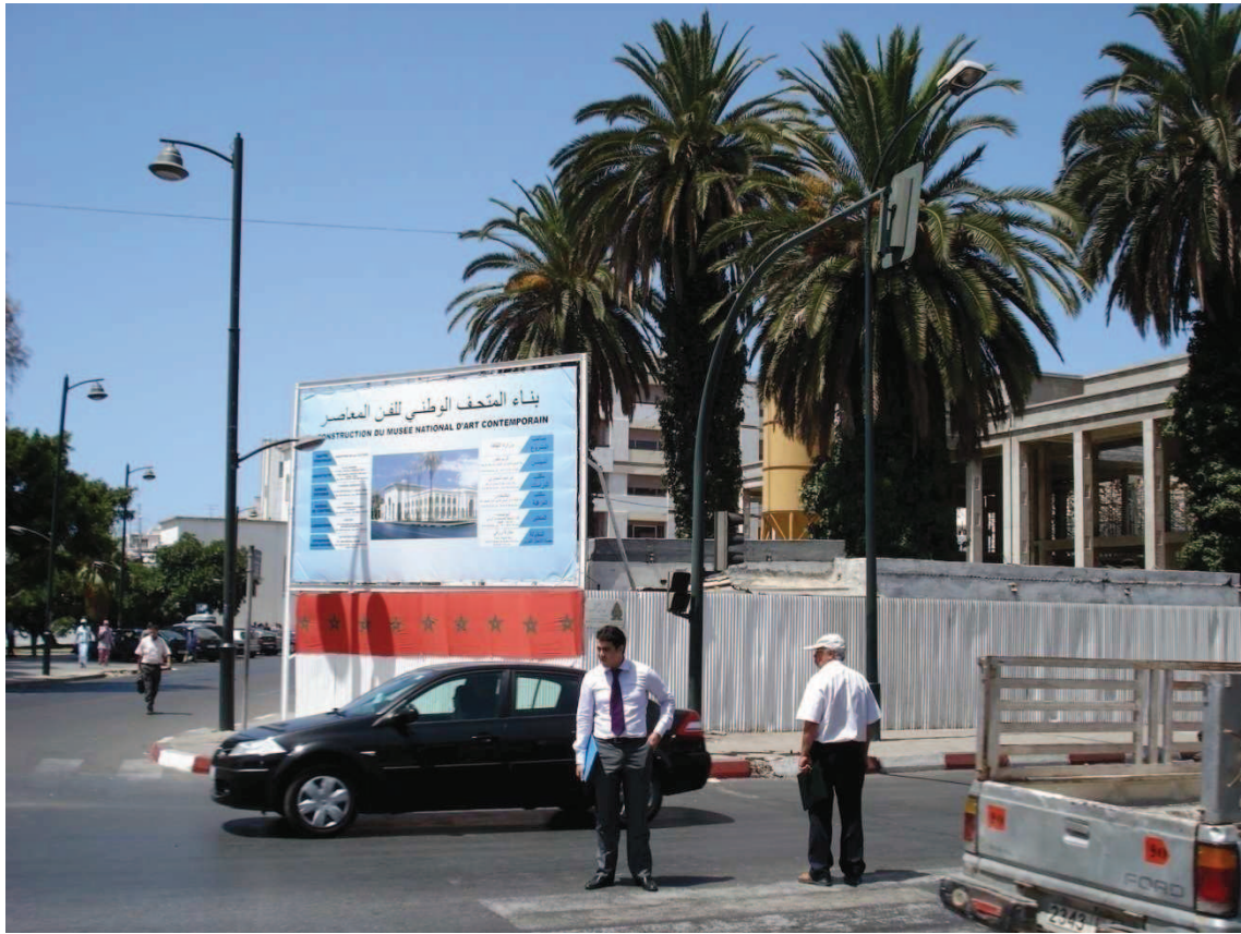
Les travaux du futur Musée d'Art Contemporain de Rabat, Marc Terrisse 2008 ©
