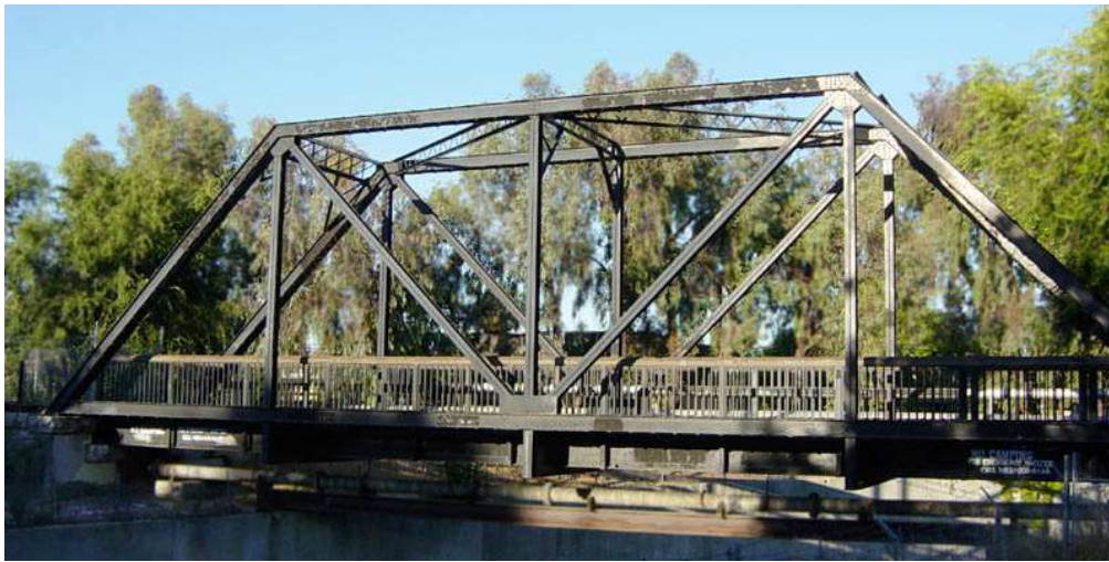
FIGURE 3.2 – Illustration d'une structure treillis pour la réalisation d'un pont.
