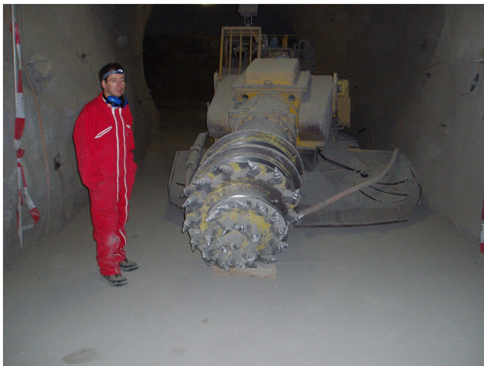
FIG. 5.5 – Machine à attaque ponctuelle utilisée pour l’excavation de la galerie 04.
