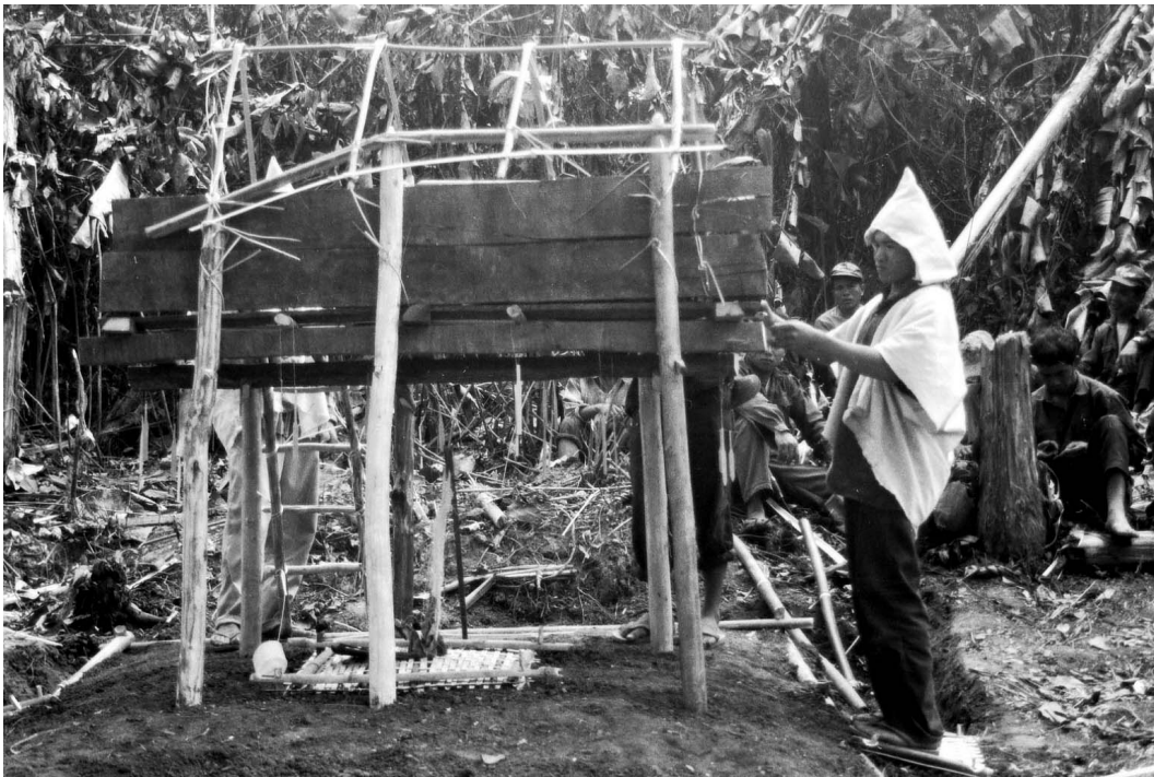
Photo I-47 L'échelle a été installée, la structure soutenant le toit posée.
