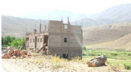
Construction en ciment, Senil, 2007
