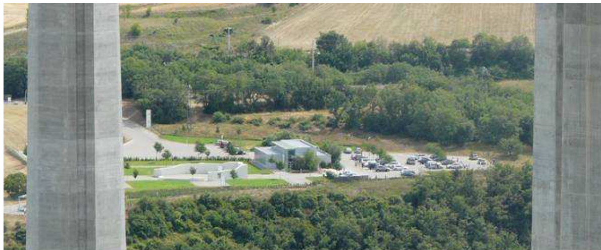
Illustration 12 : Le viaduc Espace Info photographié depuis l'aire autoroutière du viaduc
