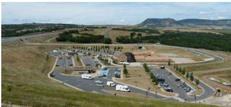
Vue générale de l'Aire du Viaduc, Senil juillet 2010
