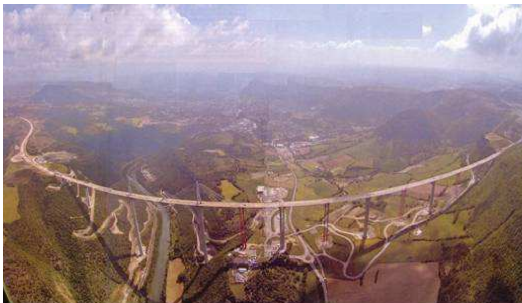
Illustration 3 : Vue générale du viaduc de Millau
