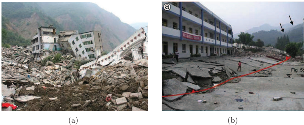
FIG 5.4 – (a) photo prise après le séisme du Wenchuan illustrant l'ampleur des dégâts. Source : http://www.iris.edu . (b) Rupture en surface sur la faille de Pengguan. On observe l'escarpement dû au mouvement chevauchant sur la faille, le bloc de gauche chevauchant le bloc de droite. Source : Liu-Zeng et al. (2009).
