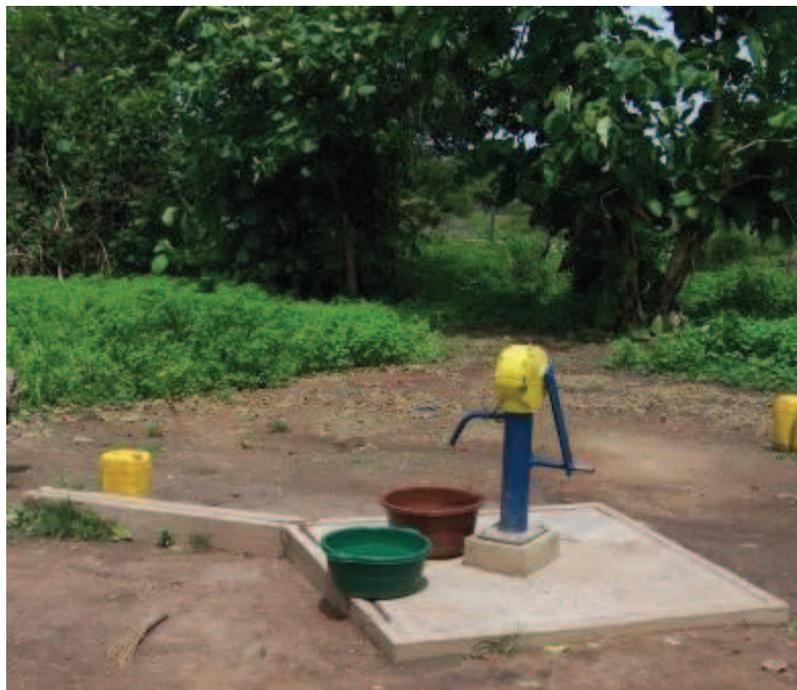
Figure 12: Puits équipé d'une pompe à manivelle
