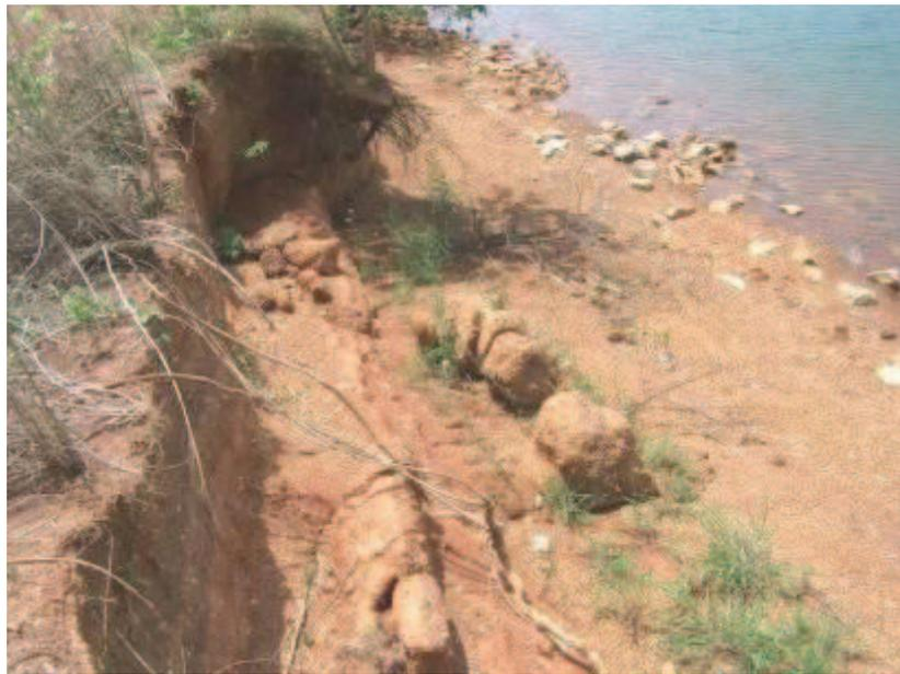
Figure 31 : Phénomène d'érosion sur la digue du barrage de Kafiné
