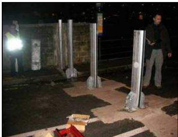
Photographie 19 : Pose des poteaux sur la partie montante de la route lors de l'exercice de simulation du 13/11/2008 (Crédit photographie : Sébastien Baron, IAV)
