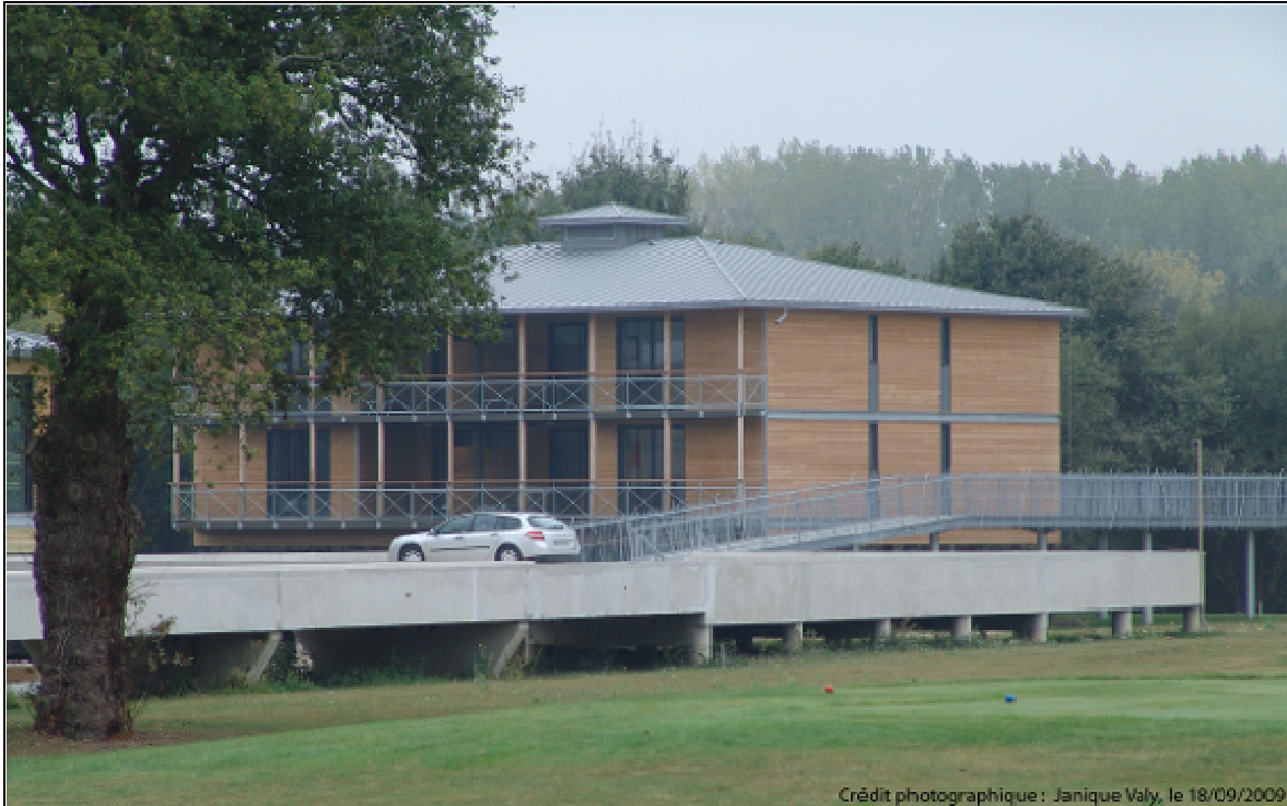
Photographie 9 : Construction sur pilotis du village résidentiel de tourisme le "Hameau de la Chaize" (Crédit photographique : Janique Valy, le 18/09/2009)
