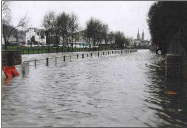
Photographie 17 : Inondation par débordement de l'Odet de la rue de l'Hippodrome le 12/12/2000 (Crédit photographique : DDE 29)
