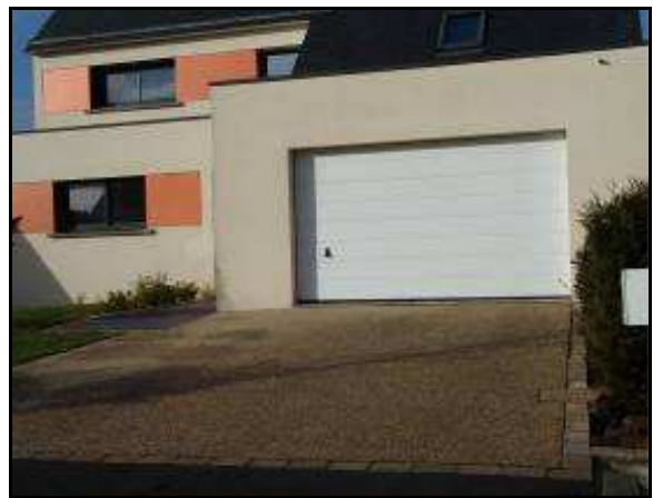
Photographie 8 : Maison avec un seuil plancher dans le Domaine de Cicé-Blossac (Crédit photographique : Janique Valy, le 26/01/2009)
