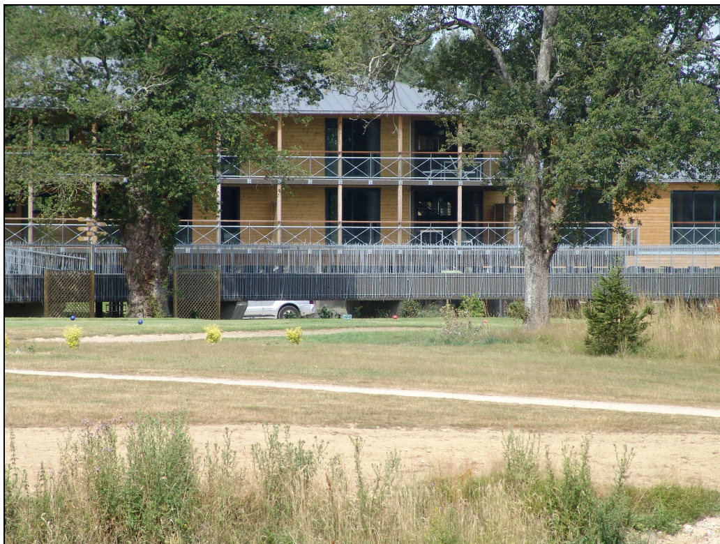
Photographie 29 : Construction sur pilotis du village résidentiel de tourisme le "Hameau de la Chaize" (Crédit photographique : Janique Valy, le 06/07/2010)
