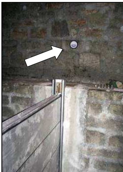
Photographie 21 : Les batardeaux montés lors de l'exercice de simulation du 13/11/2008 et le repère qui indique le niveau de la crue de 2000 (Crédit photographie : Sébastien Baron, IAV)
