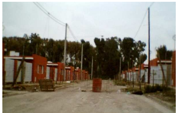
Photographie n°26 : Nouveau quartier « Molino Blanco » en construction ©Pujol, 2006
