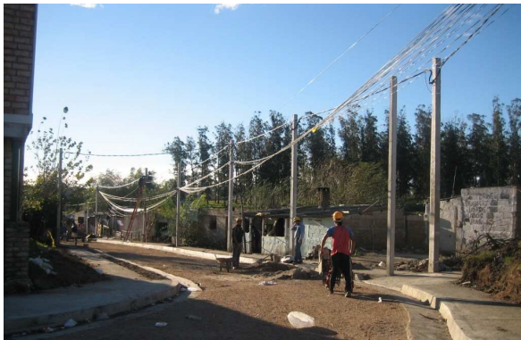
Photographie n°27 : Travaux de régularisation du quartier Nueva Esperanza ©Pujol, 2007
