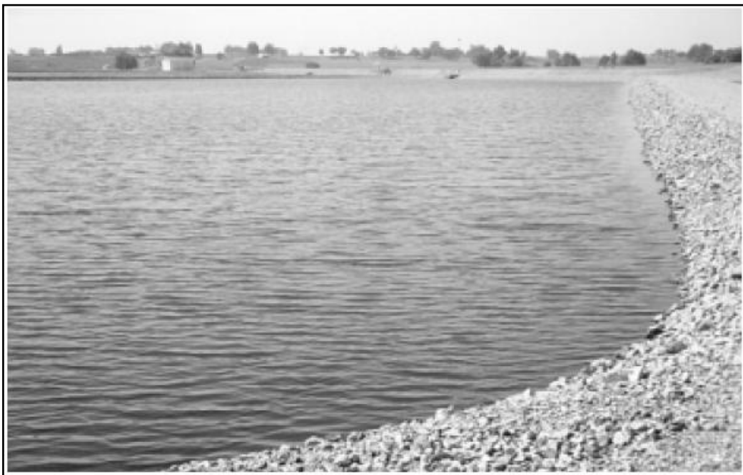
Photo 3 : Réservoir de stabilisation de la STEP de Ben Slimane
