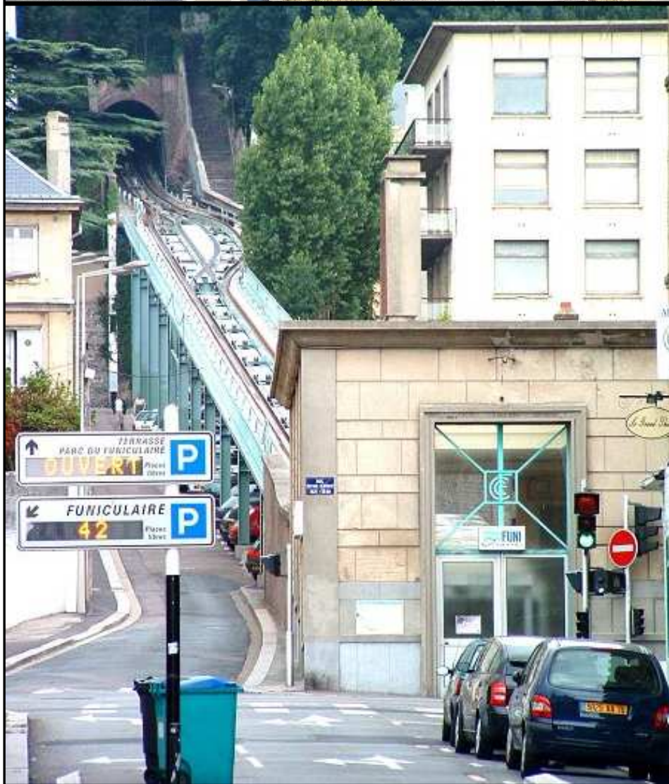
Photographies (5.7) et (5.8) Le tunnel Jenner (en haut), et le funiculaire (en bas), traits d'union entre la ville haute et la ville basse
