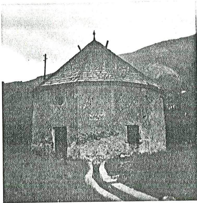
Source de la Rotonde bâtiment de la buvette - trop plein de la source qui s'écoule vers le village
