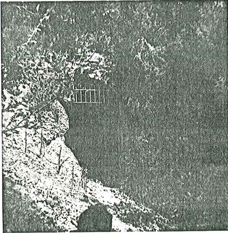
Source de l'Aigle - cavité réservoir sous la source de la Bergère T° de l'eau 11°C ,résistivité 600 ohms/cm
