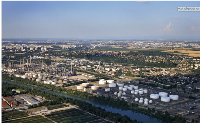
Figure 84 : Vue aérienne de la raffinerie de Feyzin
