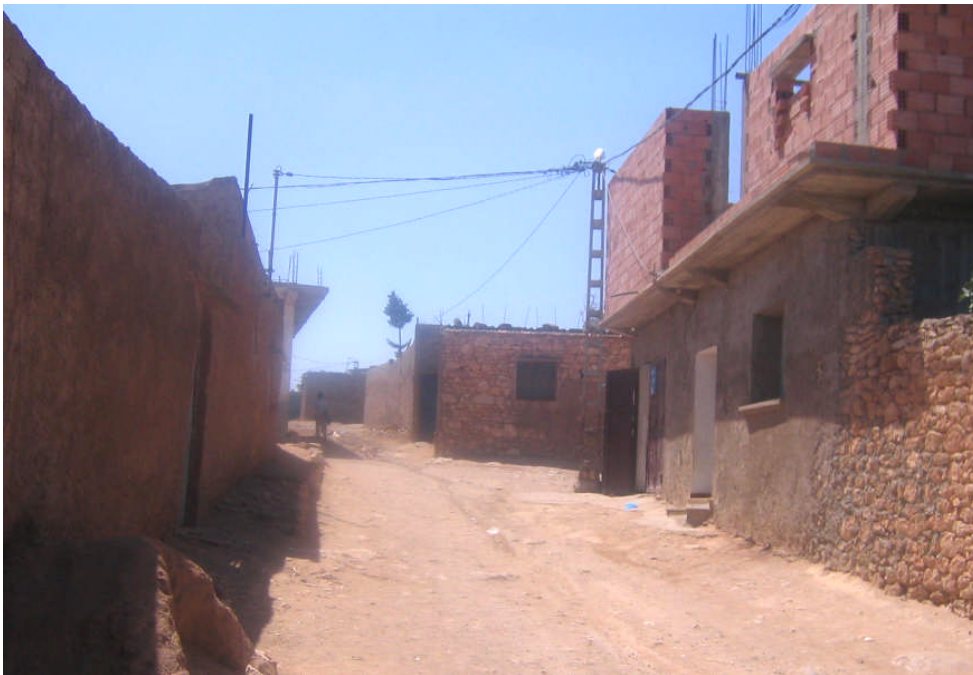
Figure 2-3 : une maison à deux niveaux avec des poteaux poutres, rendant possible une plus longue durée pour la construction, (septembre, 2008).
