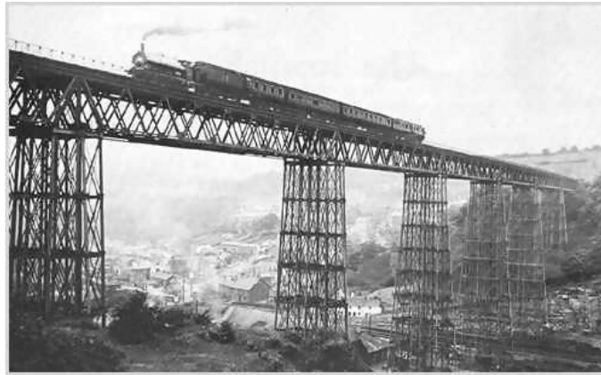
FIGURE 1.6 – Le viaduc Crumlin, qui enjambe la rivière Ebbw Vale, fut l'un des premiers viaducs totalement en acier. Il fut mis en service en 1857 alors que les exploitations minières du Pays de Galles étaient en pleine expansion. Long de 510 mètres et haut de 66 mètres, il demeura le plus haut viaduc ferroviaire du Royaume-Uni jusqu'à sa fermeture en 1964 à cause du poids devenu excessif des locomotives de l'époque (photo de 1908).
