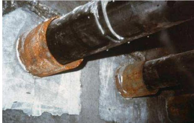
FIGURE 1.7 – Gaines de précontrainte en PEHD au niveau d'un passage de déviateur
