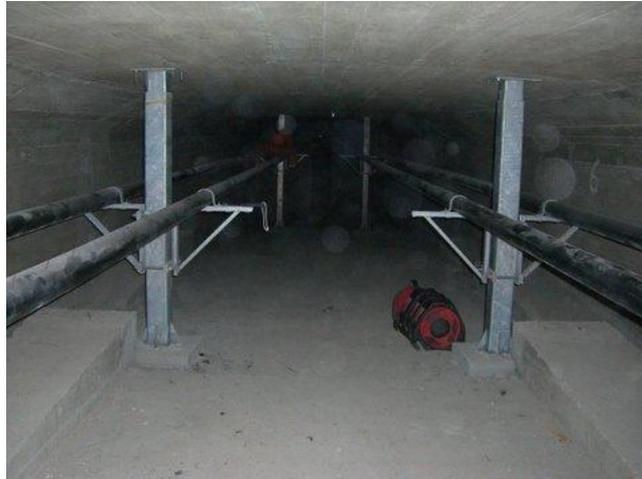
FIGURE 1.5 – *Conduits de précontrainte extérieure à l'intérieur d'un ouvrage*
