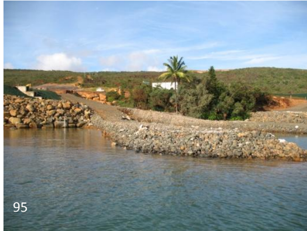
Photo 95 : Zone d'immersion du tuyau, avril 2008
