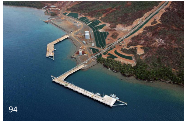
Photos 93 et 94 : Vues aériennes du port constitué de ses deux quais montés sur pieux (93) dont l'un est relié à l'usine par un convoyeur (94).
