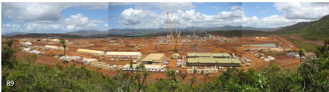
Photos 88 et 89 : Usine en travaux en 2002 et en 2006.
