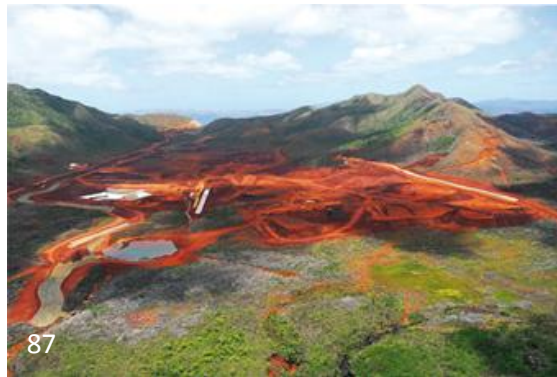
Photo 87 : Vallée de la Kwe Ouest où se construisent les bassins de stockage des résidus solides.
