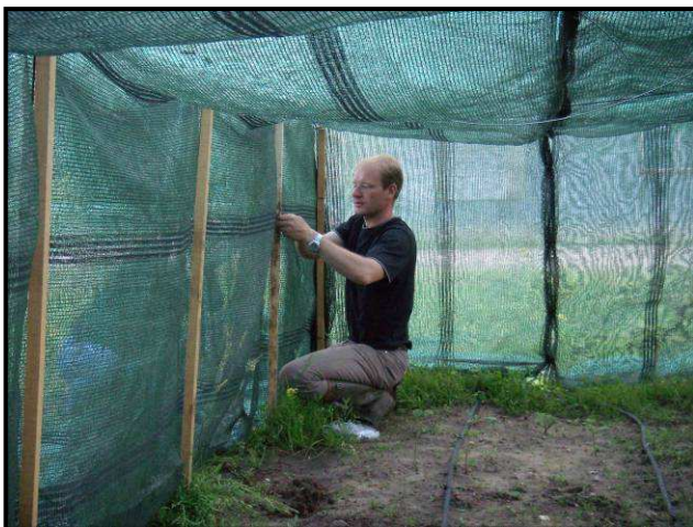
Photo 16. Phase d'installation des ombrières.
