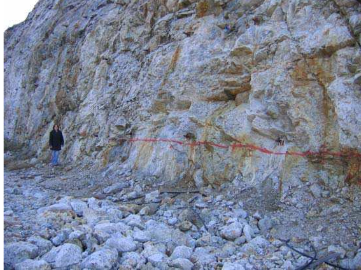
Figure 54 : Photo des déblais rocheux en cours de réalisation et exemple de ligne de mesure exploitée
