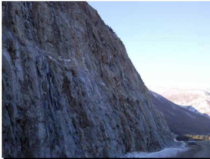
Figure 55 : Photo des déblais rocheux réalisés
