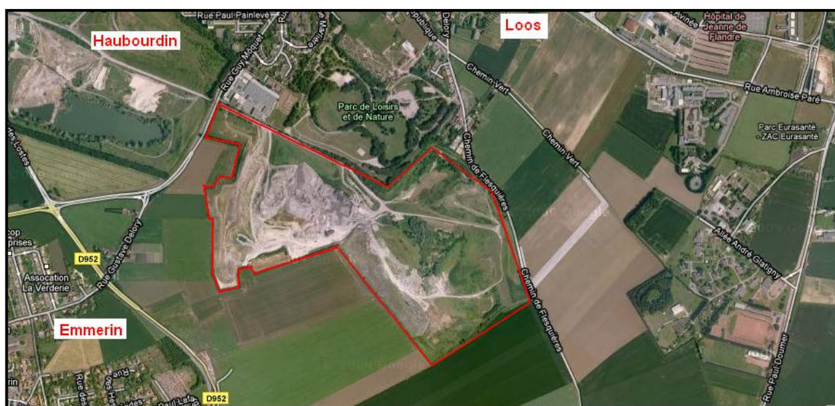
Figure 2.10 : Vue satellite de l'emprise de la carrière NORMAT
