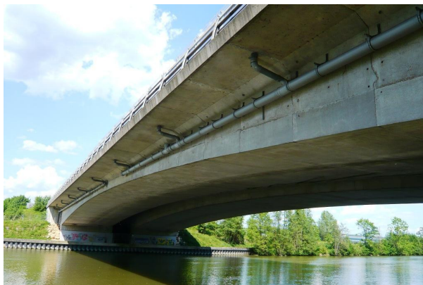
FIGURE 6.2 – Vue de l'ensemble du pont PI-57.
