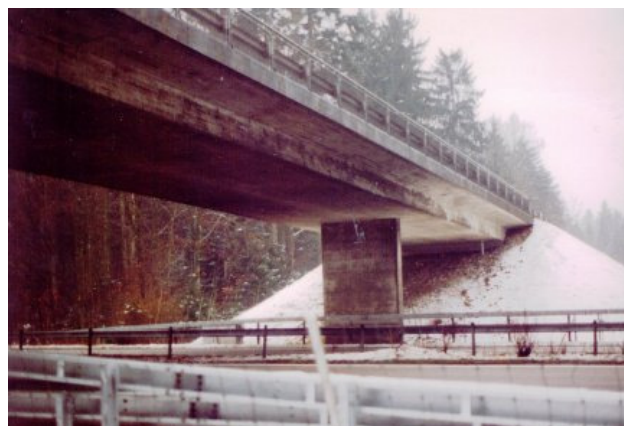
(a) Vue du pont
