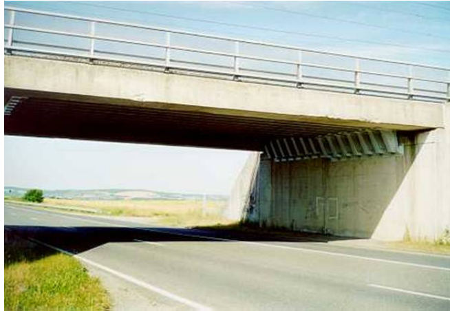
FIGURE 5.2 – Vue de l'ensemble du pont-rail.
