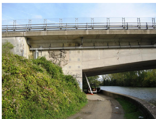
(a) Vue de la cullée du pont
