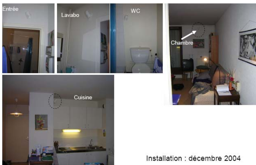
Figure 2-3 - Installation des capteurs dans un appartement
