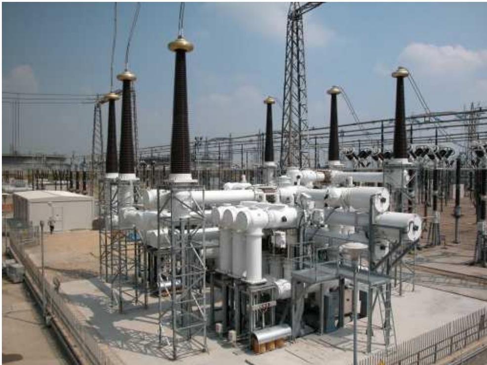
Appareillage blindé utilisé à 420 kV.
