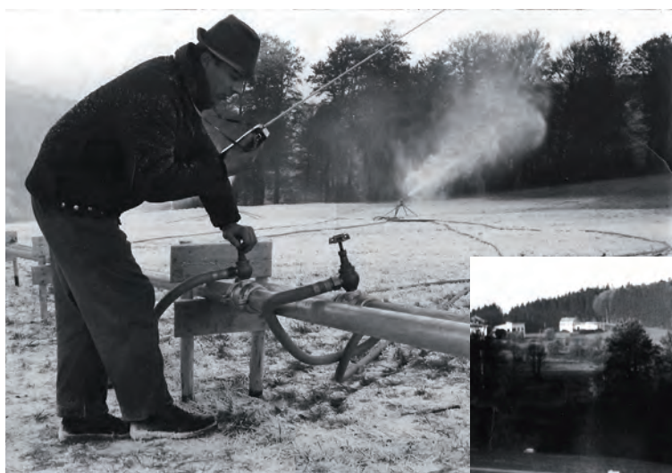
Photo 3.2 : Réglage de l'installation d'enneigement du Champ du Feu en 1963 (cliché : Auteur inconnu, 1963 ; transmis par N. Bureth, 2009)
