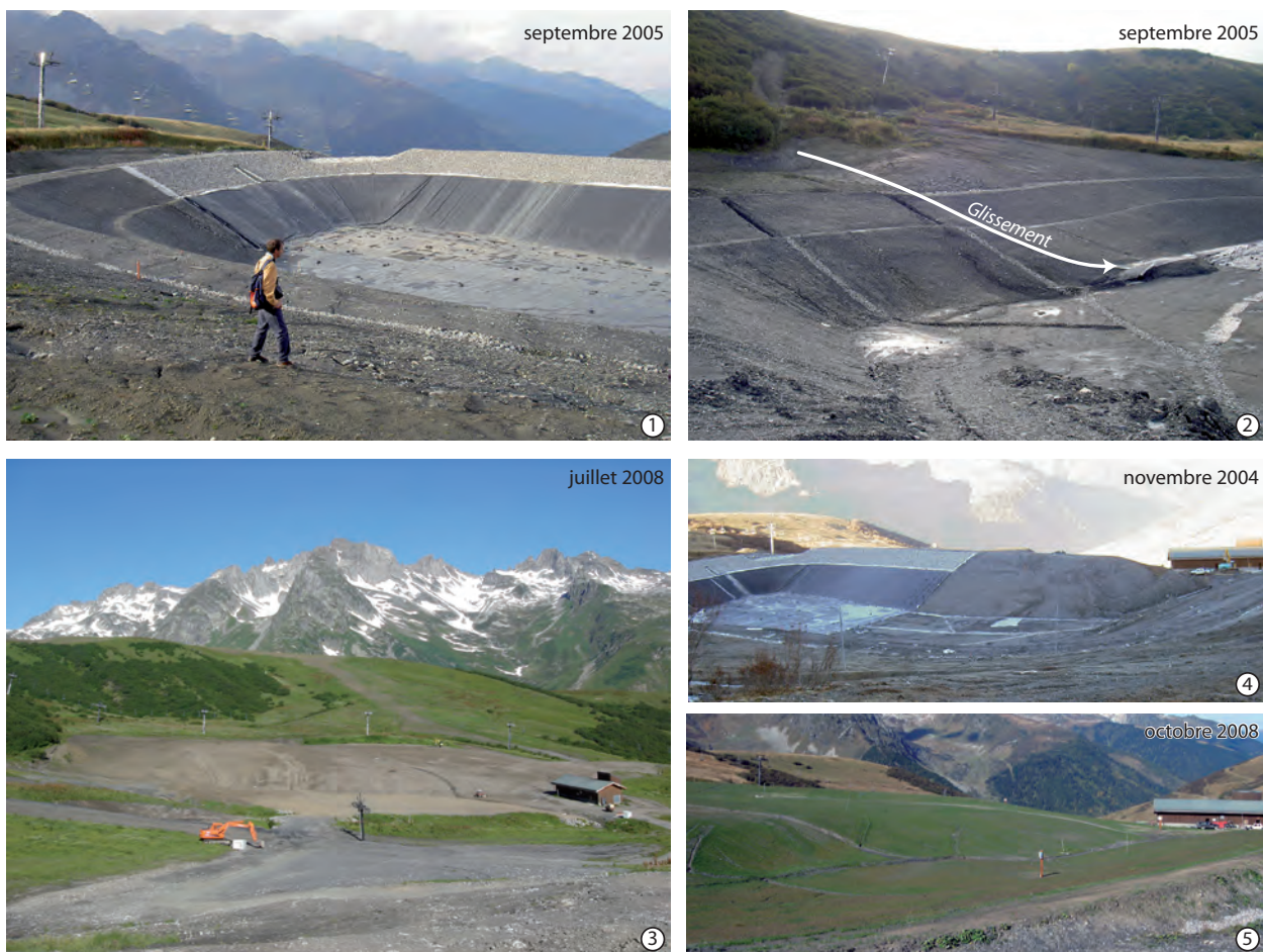
Figure 3.27 : Le glissement de la retenue de Baudin (Valmorel, Savoie) (1 et 2) et la réhabilitation du site (3, 4 et 5) (clichés : DDAF 73 [1, 2, 4 et 5] ; P. Paccard [3])
