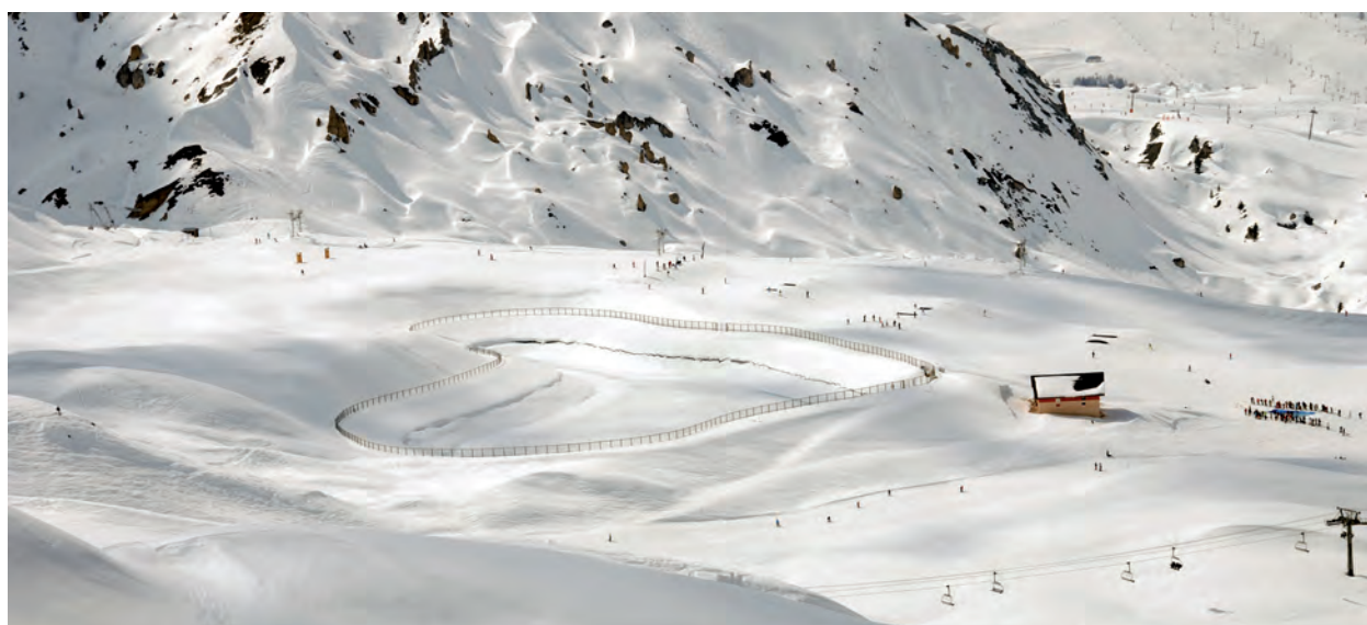
Photo 8.5 : Un ouvrage de grande capacité sur le domaine skiable de la Plagne, Savoie (cliché : P. Paccard, le 14/04/2010)
