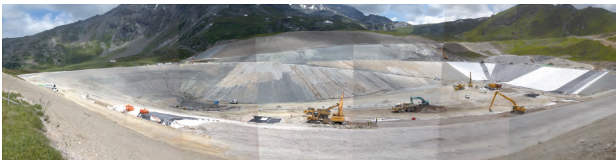
Photo 8.2 : La retenue de l'Adret des Tuffes en construction, Arc 2000, Savoie (cliché : P. Paccard, le 22/07/2008). Les engins de chantier donnent l'échelle de l'ouvrage : des dimensions colossales. A l'heure actuelle, c'est le plus grand ouvrage français destiné à la production de neige : 404 000 m 3 de capacité utile.
