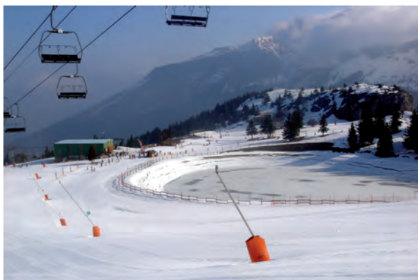
Photo 6.10 : La retenue du Pré des Preys en fin de saison hivernale (cliché : P. Paccard, le 05/04/2009). A l'altitude 1520 mètres, cet ouvrage a une capacité utile de 73 000 m 3 .
