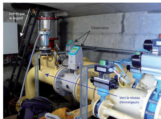
Photo 5.8 : Vue de l'intérieur de la chambre des vannes des Estaris (cliché : P. Paccard, le 09/04/2009)
