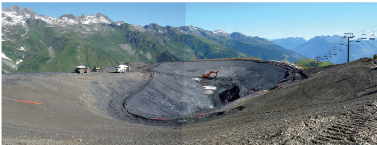
Photo 8.4 : La retenue de l'Arenouillaz en construction, Valmorel, Savoie (cliché : P. Paccard, le 10/07/2008). D'une capacité utile de 35 000 m 3 , cette retenue se situe à 2000 mètres d'altitude. La réalisation d'un ouvrage de ce type implique d'importants travaux de terrassement.
