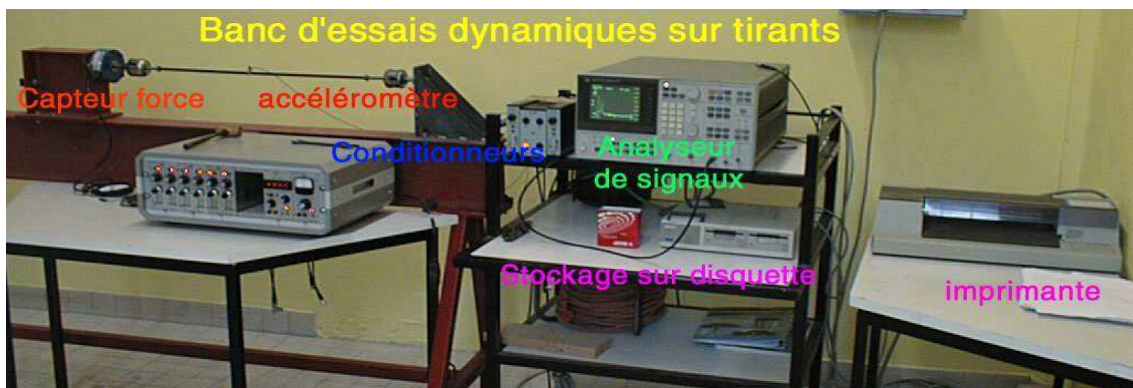
Figure 23. Dispositif d'étalonnage des mesures de tension des tirants.
