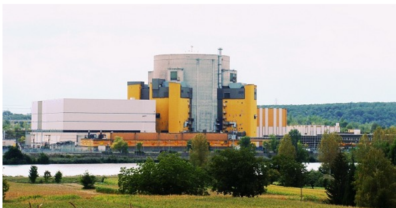
FIGURE 1.7: Vue terrestre du prototype pré-industriel Superphénix (Photo CEA).
