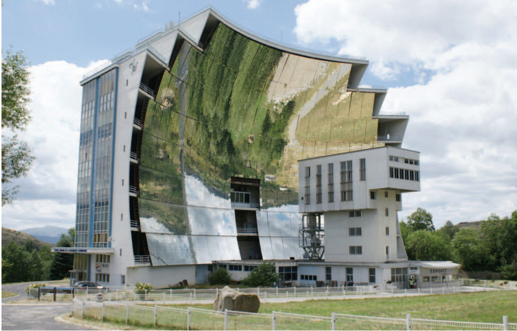
Figure 1-4 : Capteur solaire a concentration : four solaire d'Odeillo, puissance thermique 1MW, source PROMES [2010].
