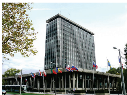
Figure 4-9 : HDV - Vue globale de la tour et du bâtiment périphérique.
