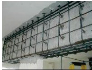
(b) Mise en œuvre d'armatures complémentaires.
