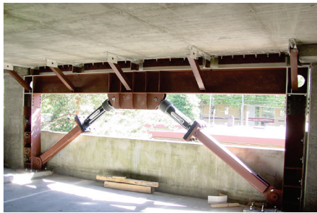
Mise en place de vérins [Staaleson, 2005]
