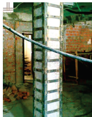
Figure 1-32 : Confortement - Renforcement d'un poteau par plats métalliques.
