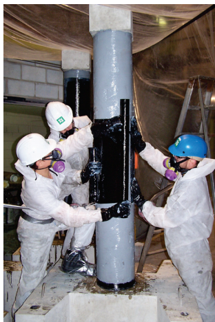
Figure 1-34 : Confinement d'un poteau par TFC uniaxial.
