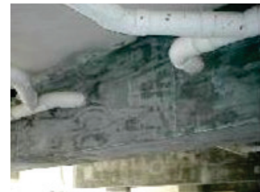
(a) Élément après reprise de bétonnage.
