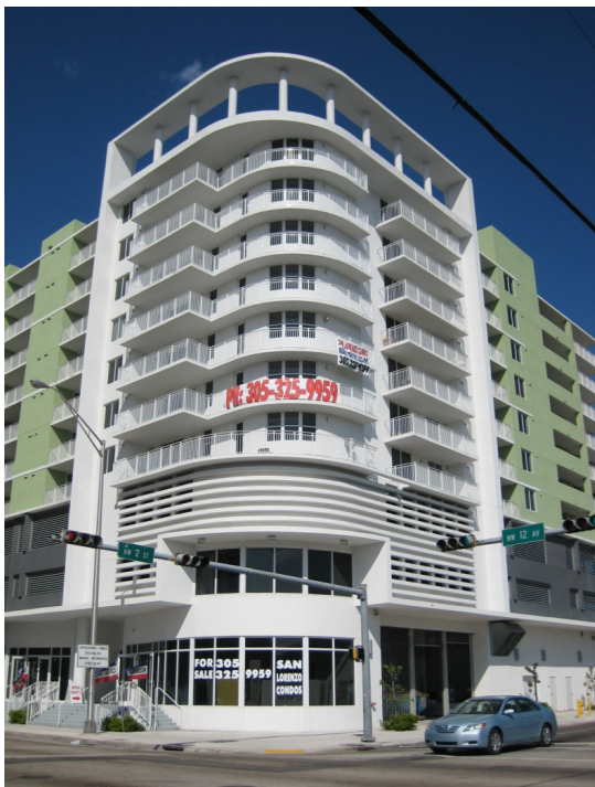
Photo 8 : Condominium San Lazaro à proximité de la rivière Miami à Little Havana (NW 2 th street / 12 th avenue)
