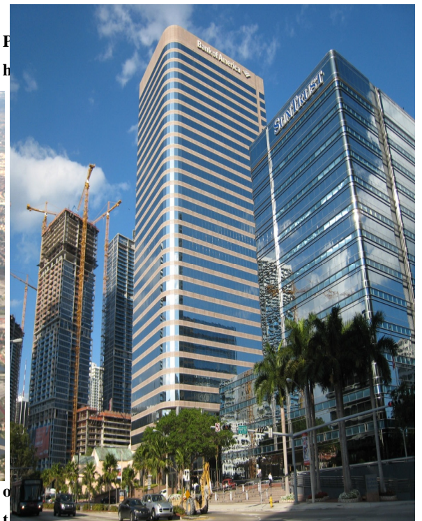
Photo 12 : Brickell, le centre financier et ses chantiers de construction permanents
