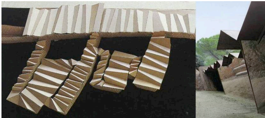
Figure 76. RCR, exemple du chai « Bell-Hoe winery » construit en Espagne utilisant à plusieurs reprises l'opération « plisser » pour la conception de la toiture.
