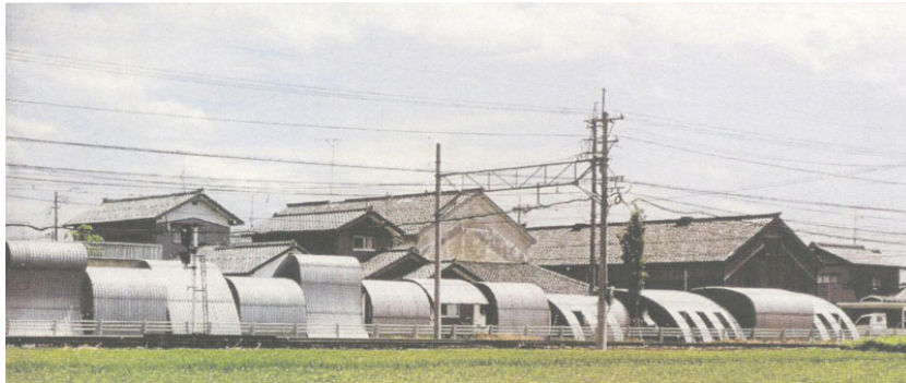
Figure 79. Gare ferroviaire et abri à bicyclettes, Fukui, Japon, Shuhei Endo Architect Institute.
