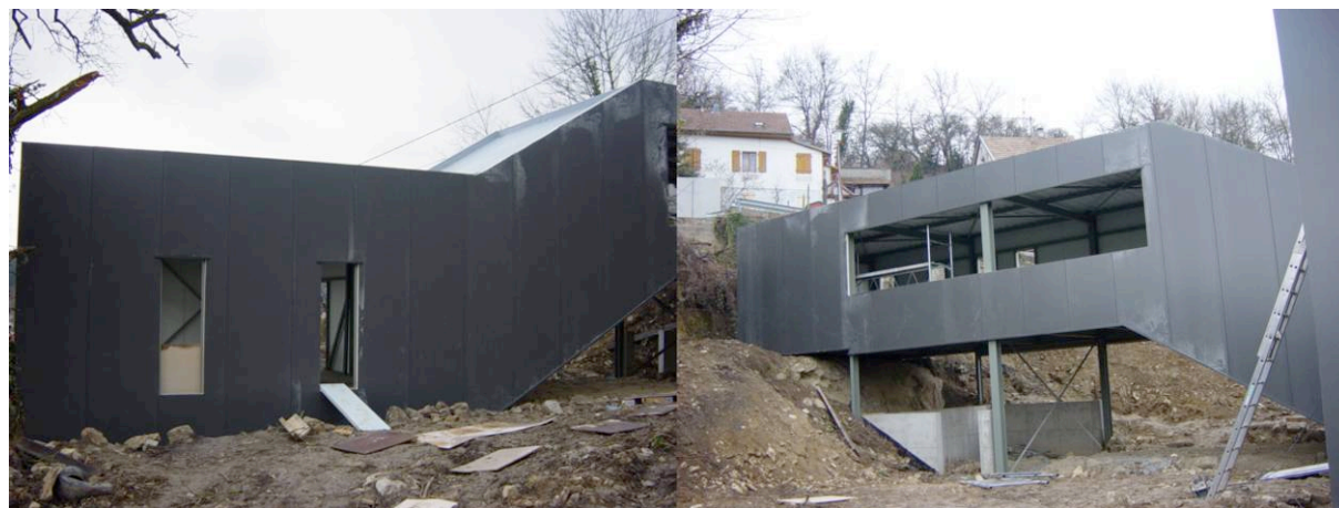
Figure 190. Maison Doll en cours de réalisation.
