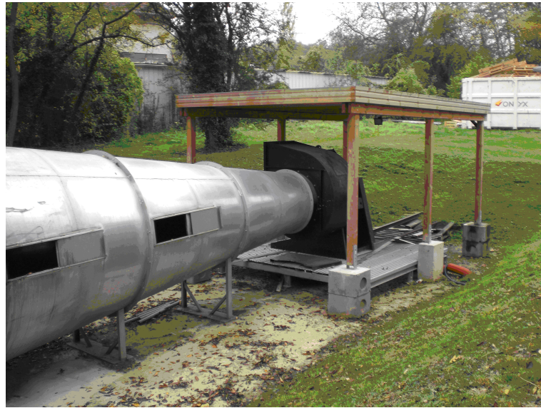
FIG. III.2 – Vue du convergent et de l'unité de ventilation
