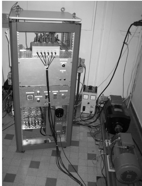
FIG. A.1 – Photographie du banc de test
