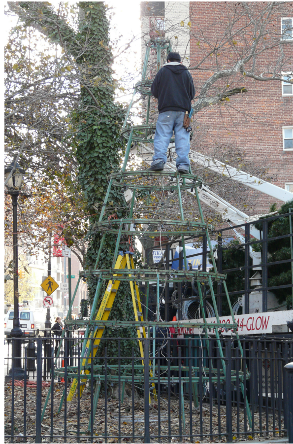
Photo 45. Jackson Heights espace public : Installation d'un arbre de Noël sur une place
