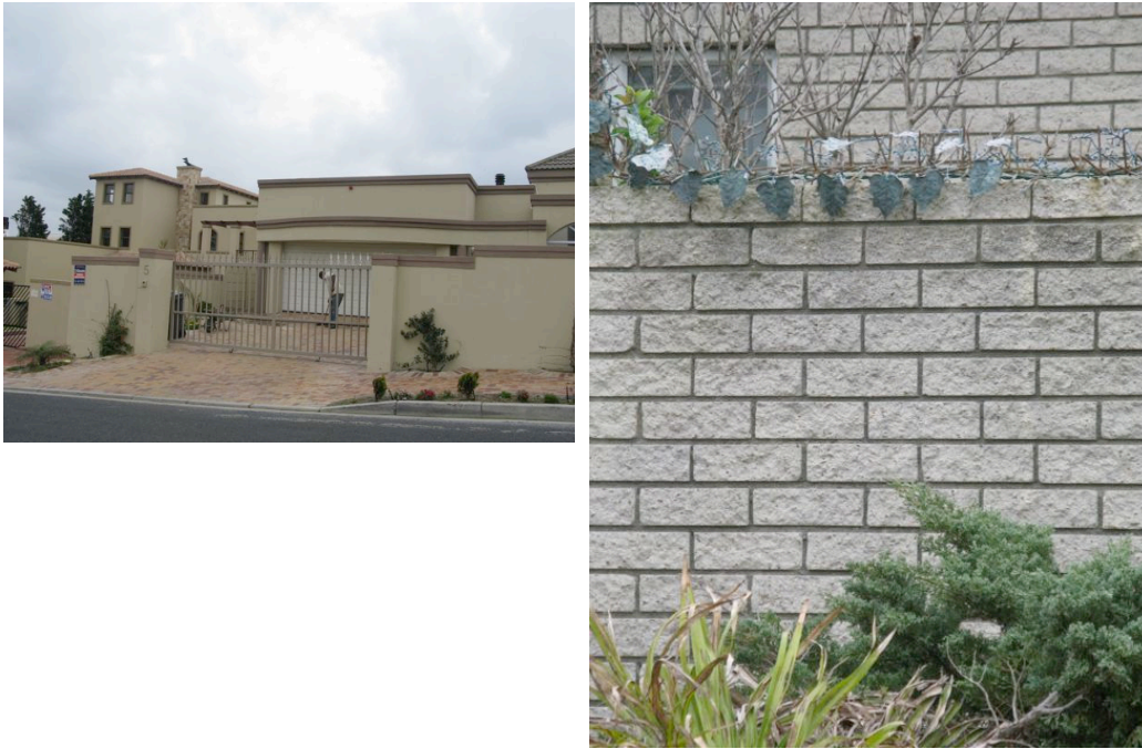
Figure 77 : Espaces publics traditionnels en déclin et fortification de l'espace domestique
