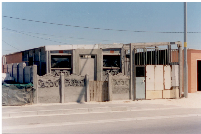
Figure 57 : Extension et sécurisation de l'habitat, Delft South.
