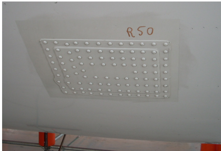
FIG. I.21 - Réparation par patch riveté sur fuselage de Boeing
