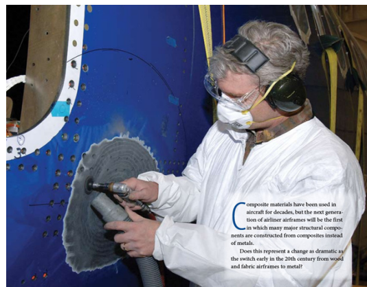
FIG. I.23 - Opération de ponçage de la zone endommagée directement sur fuselage [Werfelman, 2007]
