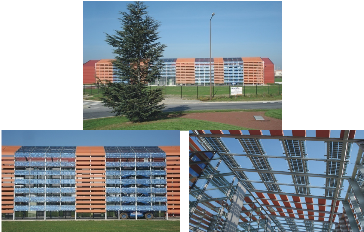
Figure I-8. Exemple d'application raccordée réseau : l'usine TENESOL de Toulouse.
