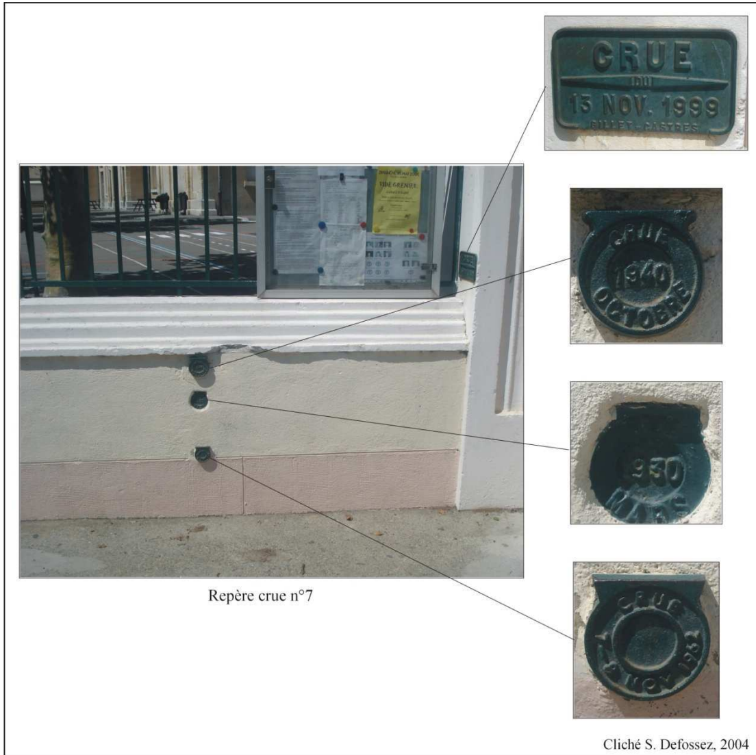
Photographie 7.3 : Repères de crue officiels à l'école communale, Cuxac-d'Aude
