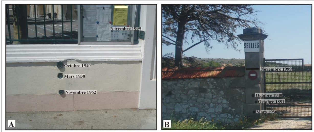
Photographie 6.1 : Repères de crue de grande ampleur à Cuxac d'Aude (Defossez, 2004)
