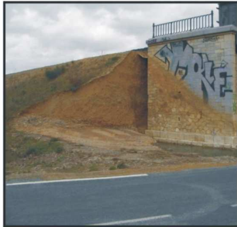
A : Remblai RFF fragilisé suite aux inondations de novembre 2005
