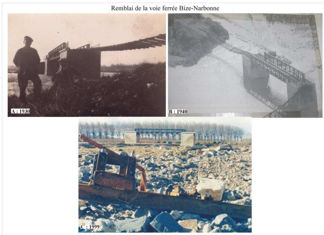
Photographie 6.2 : Détérioration du remblai SNCF lors des inondations de 1930, 1940, 1999 (Clichés : 1930 : cliché de Mme Fraisse remis à F. Vinet ; 1940, 1999 : M. Bonavida).
