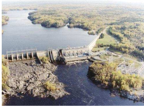
FIGURE 2.5 – Vue aérienne de la centrale dans laquelle est installée l’aspirateur étudié
